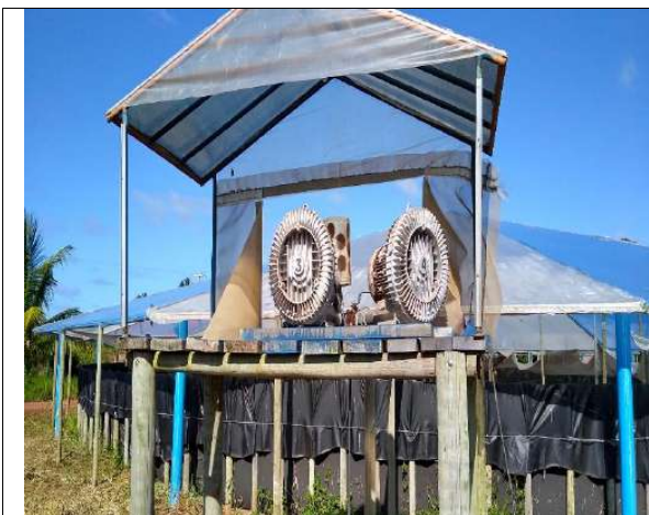
Tanques de 500.000 litros, sistema intensivo, estacas de eucalipto, manta pvc, cordoalha, coberta metálica e filme plástico
