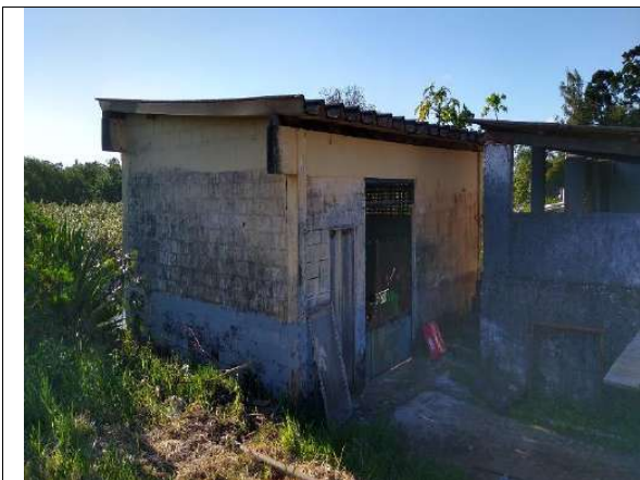
Galpão oficina e serviços de fibra
