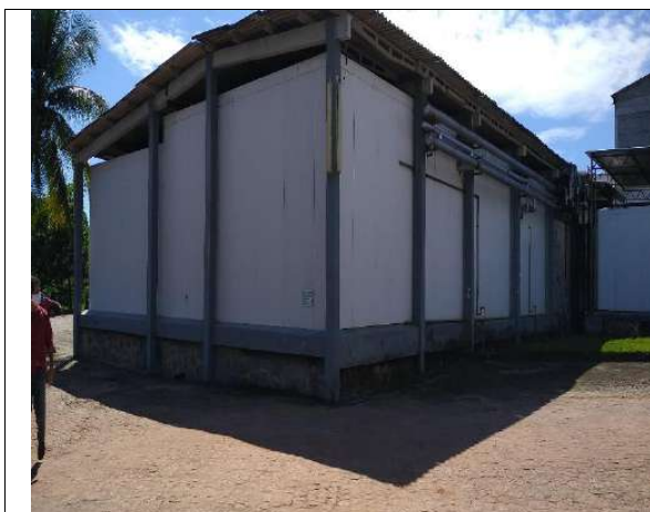
Câmaras de estocagem e túneis de congelamento - Frigorífico
