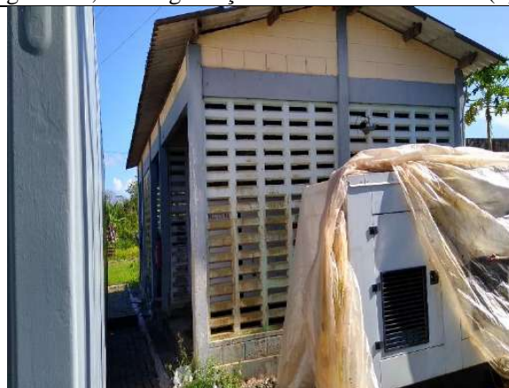
Galpão abrigo do Gerador
