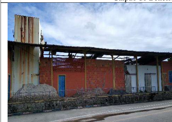
Galpão do Beneficiamento - Desativado
