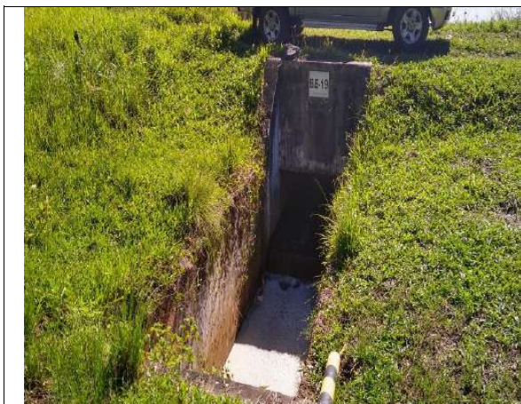
Comportas em estrutura de concreto de despesca dos viveiros
