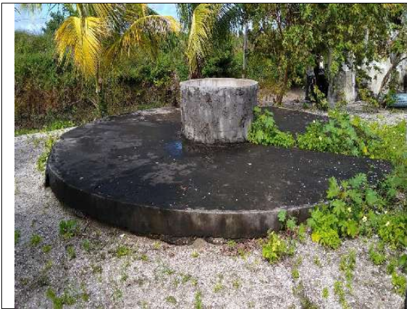
Bases em concreto para tanques
