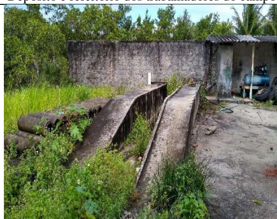
Dique de lavagem
