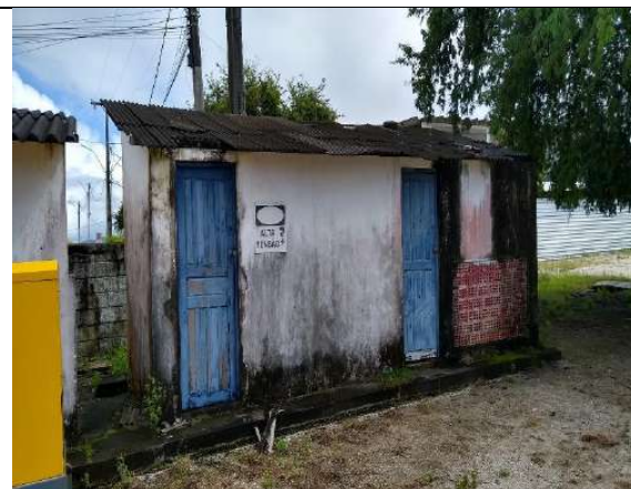
Casa de força e depósito
