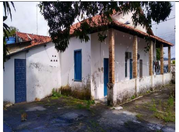
Refeitório e Alojamento
