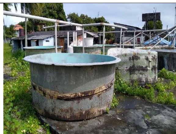
Bases em concreto para tanques
