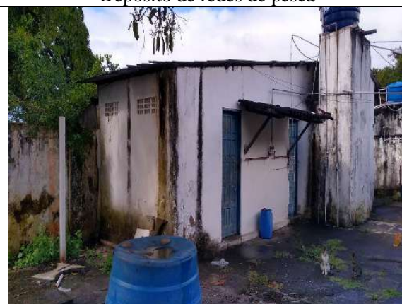
Depósito e vestiário
