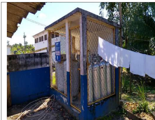
Abrigo dos botijões de gas - Refeitório - sede da Fazenda
