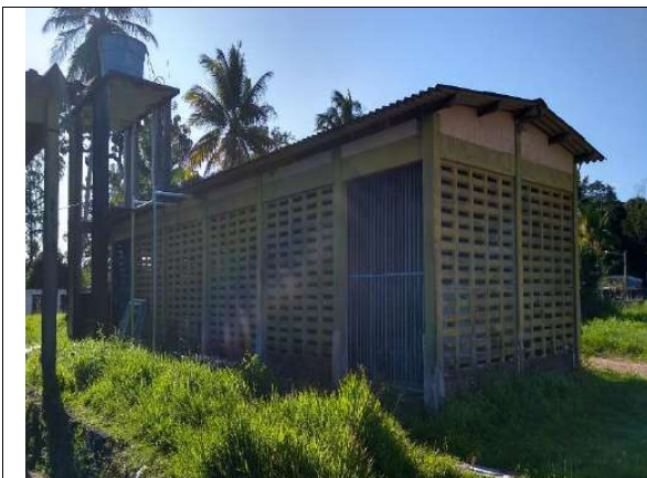
Galpão do tratamento de água
