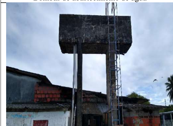
Caixa D'água elevada
