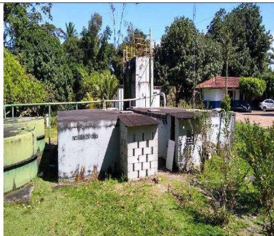
2 Reservatórios de água - Sede da Fazenda
