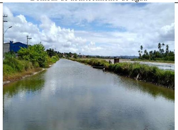
Canal de Abastecimento dos viveiros
