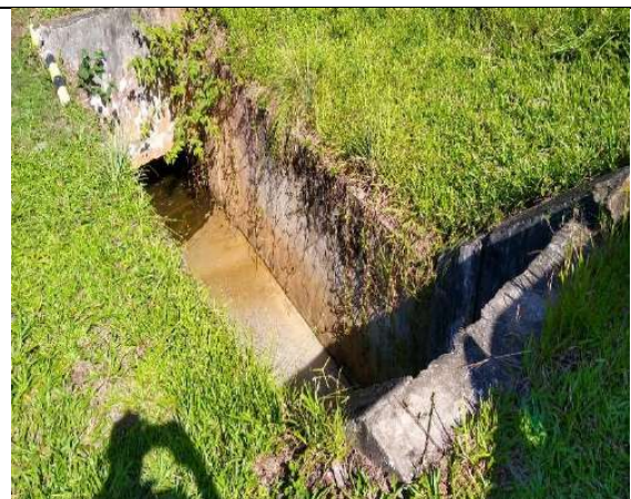
Comportas em estrutura de concreto de esgotamento dos viveiros
