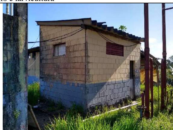
Galpão dos filtros e ração reprodutivas
