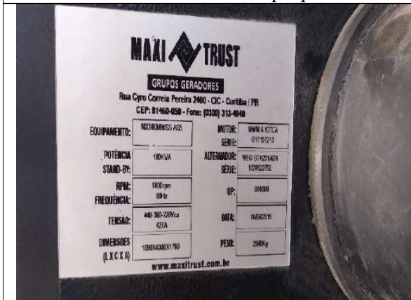
Grupo Gerador Maxi Trust potência 180 KVA - plaqueta
