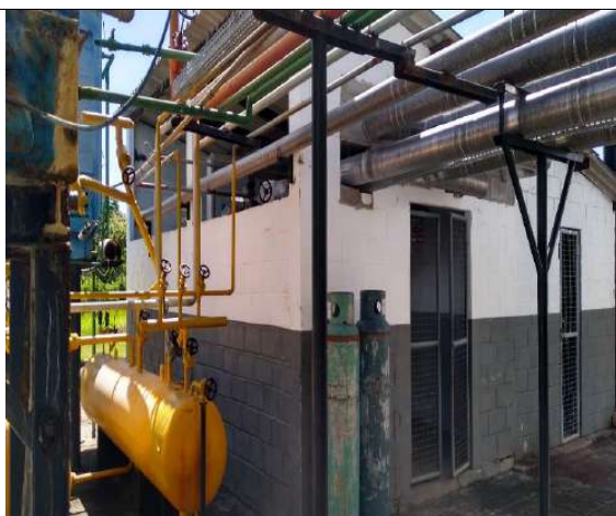
Casa da estação de água gelada - sede da fazenda
