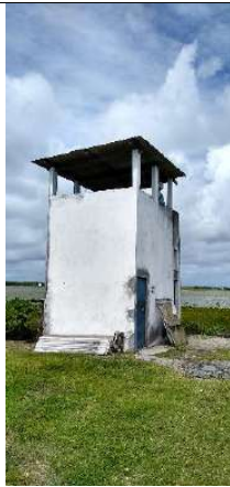
Escritório e torre de vigilância de campo
