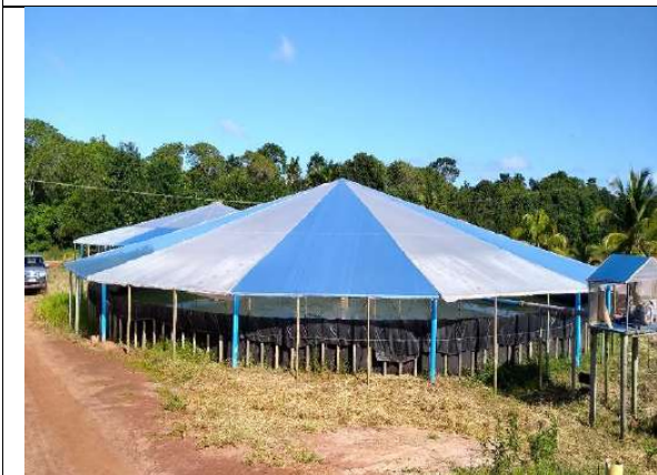
Tanques de 500.000 litros, sistema intensivo, estacas de eucalipto, manta pvc, cordoalha, coberta metálica e filme plástico
