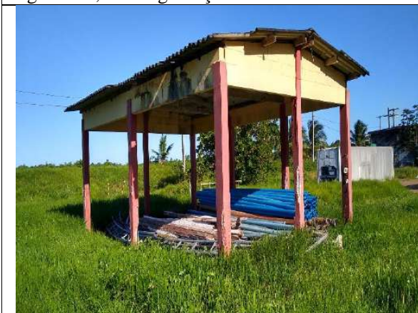
Galpão abrigo dos filtros dos tanques de Algas
