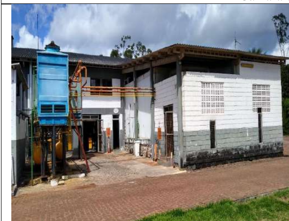
Câmaras de estocagem e túneis de congelamento - casa de máquinas - Frigorífico
