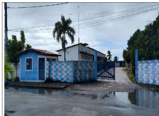
Guarita de acesso à propriedade
