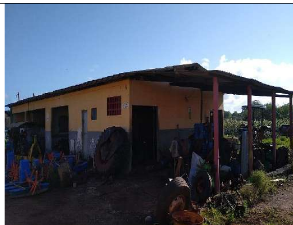
Galpão oficina e manutenção de bombas e motores
