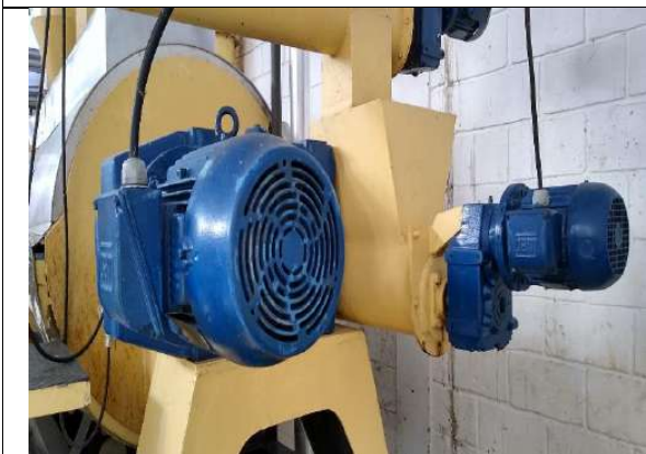
Digestores contínuos - Fab SNT - Casa de Farinha
